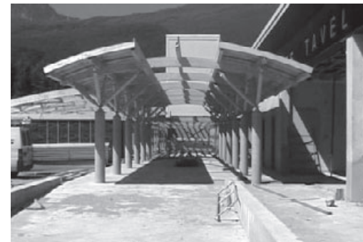
L'école Tavel en chantier
