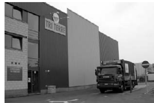
L'entrepôt du tri à Herstal.
