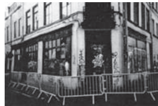
... Et des points faibles, à Fives
