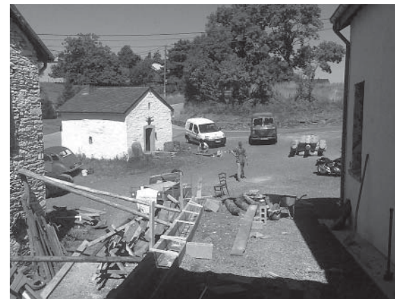
Le chantier pour accueillir l'école.
