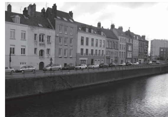
Le quai de la Concorde et le Canal de Jonction
